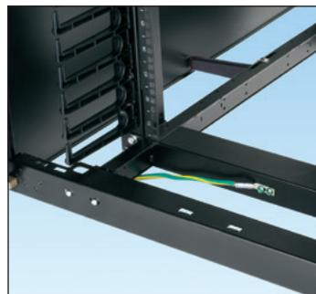
**Unión de los gabinetes mediante una sola conexión al MCBN, que reduce el tiempo de instalación**
