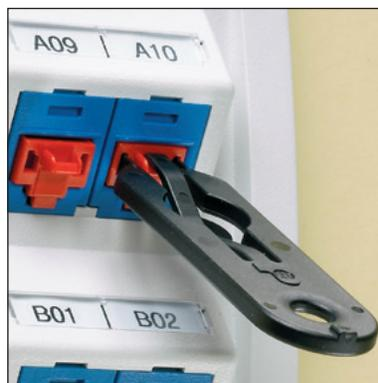
**Para liberarlo:** Inserte la herramienta especial para remoción que se anexa al dispositivo de bloqueo RJ45
